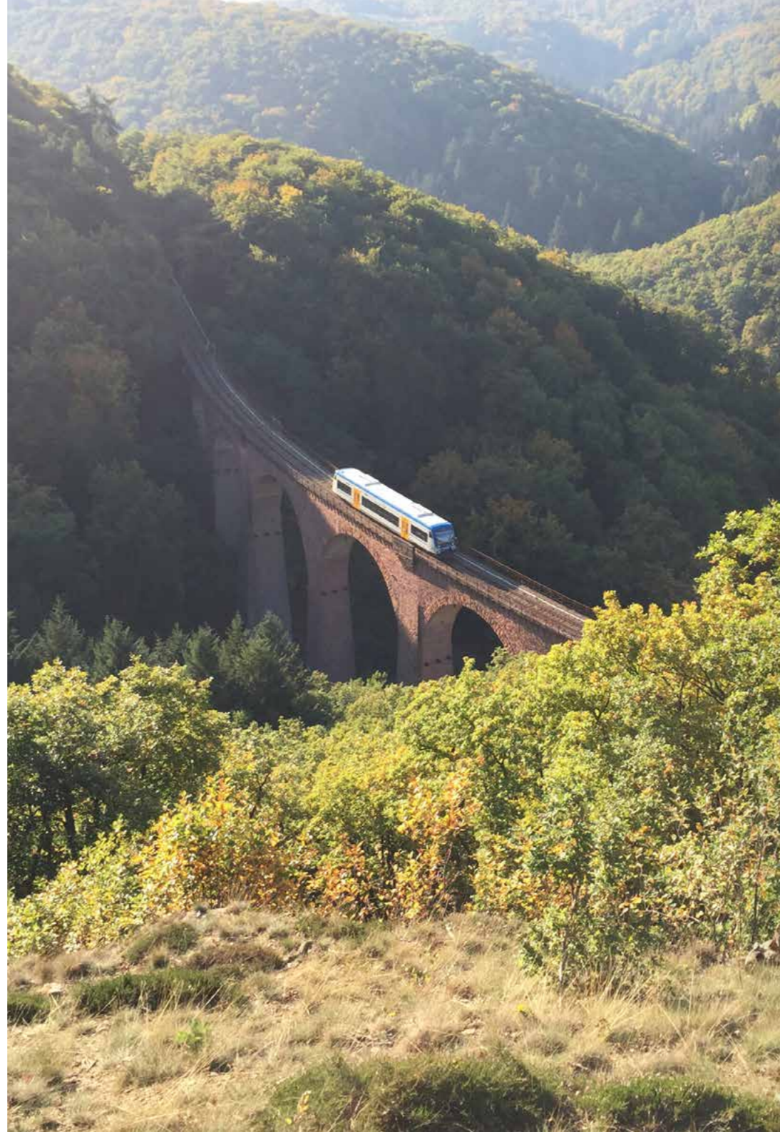
Das Hubertus-Viadukt im Verlauf der Hunsrückbahn.
