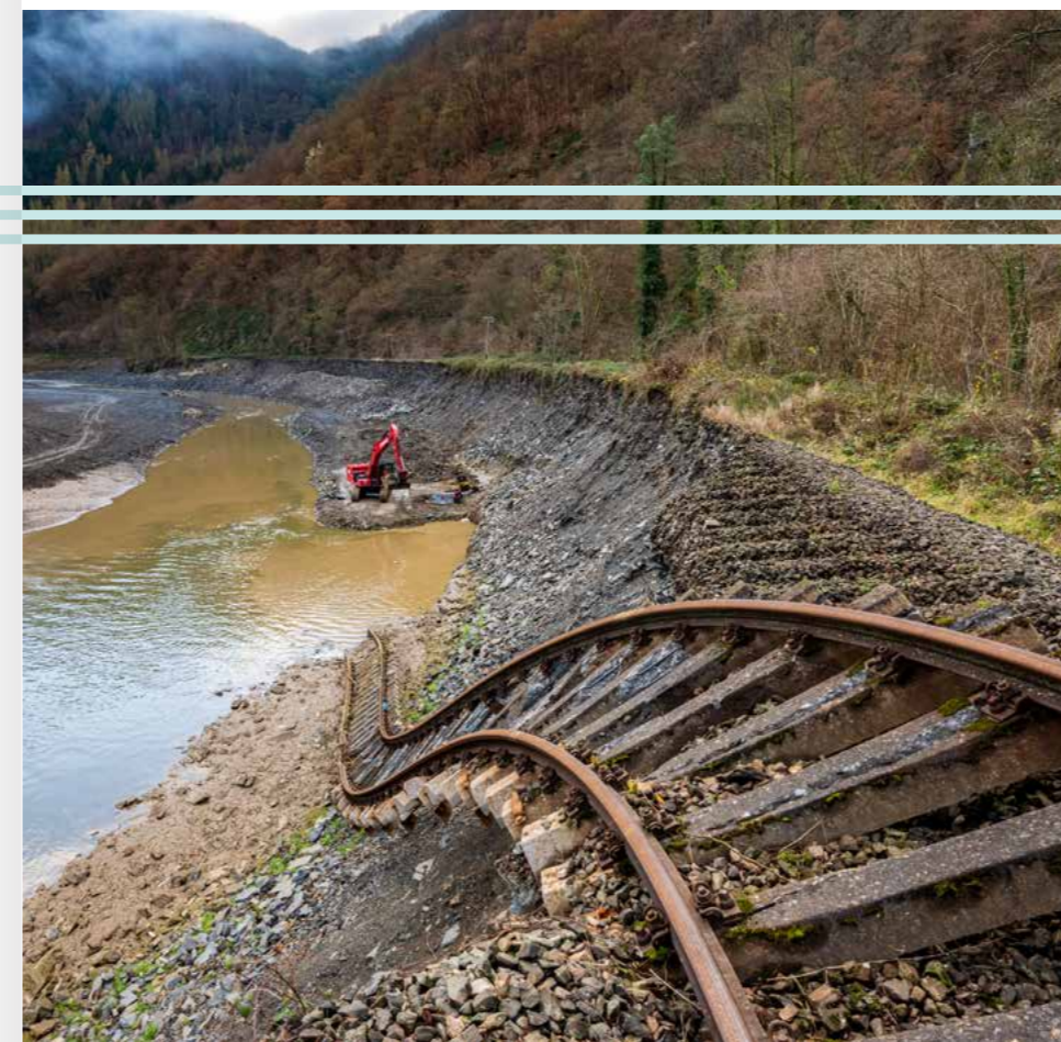
Die gewaltige Kraft der Ahrflut zerstörte die Gleise der Ahrtalbahn.
