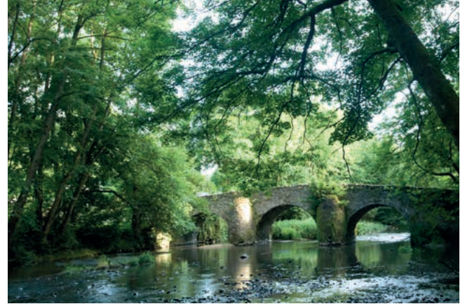
Brücke bei der Klosteranlage Marienstatt
